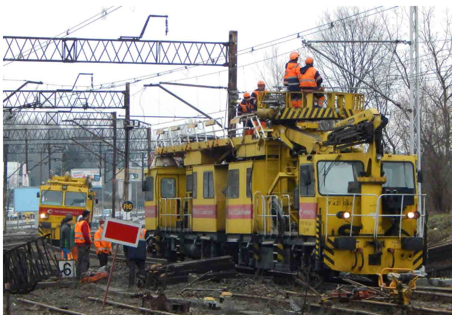
Pociąg sieciowy PKP Energetyka w trakcie naprawy sieci trakcyjnej
